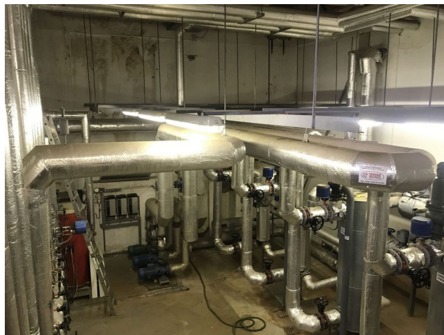
foto /2/ Interiér strojovny ÚT + pohled na nejvíce vlhkostí zasaženou stěnu
