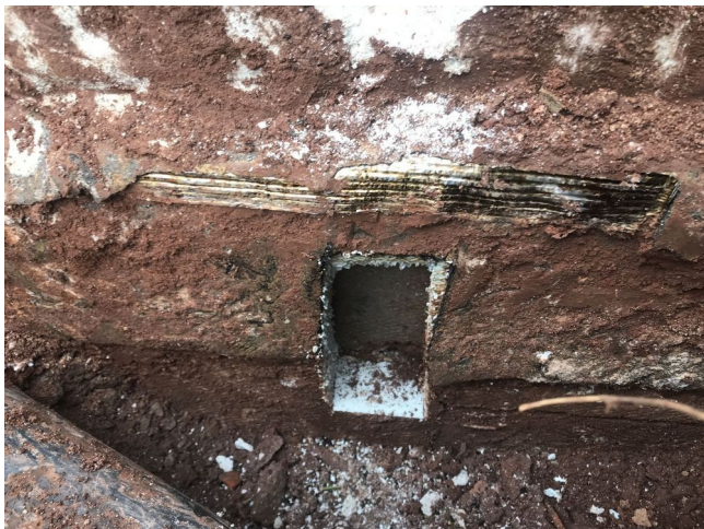
foto /7/ Vodorovná hydroizolace z asfaltového pásu
