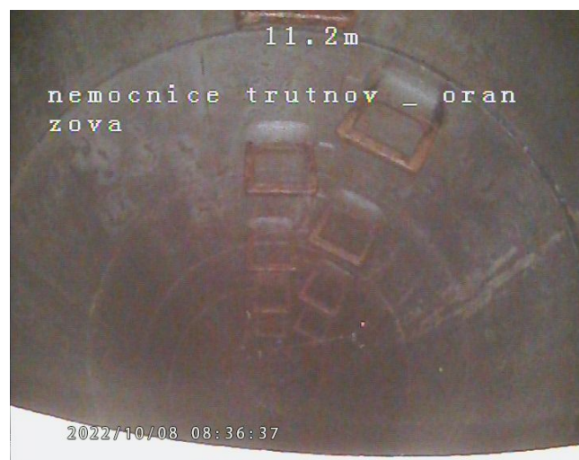
foto /17/ Revizní šachta + hlavní kanalizační stoka
