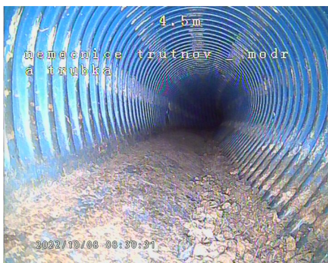
foto /12/ Drenážní potrubí Ø 125 mm
