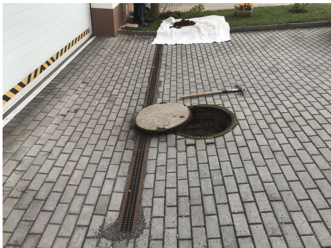
foto /10/ Revizní šachta před garážovými vraty
