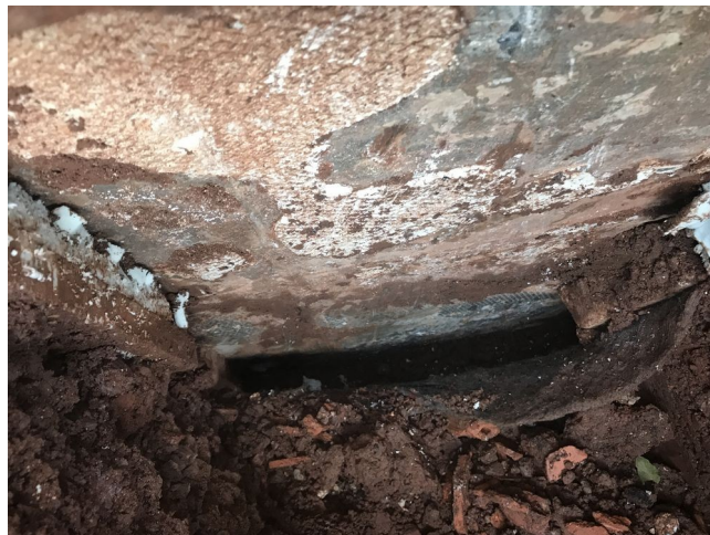
foto /8/ Betonová stěna bez svislé hydroizolace
