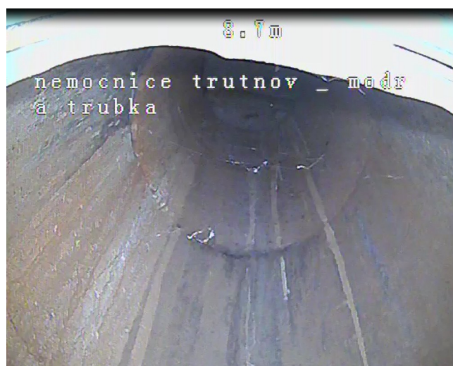
foto /13/ Betonová šachta drenážního potrubí
