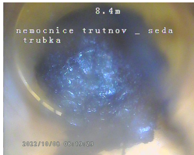
foto /15/ Neprůchozí napojení druhého odvodňovacího žlabu
