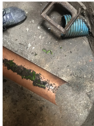
foto /11/ Drenážní potrubí (modré) + odvodní kanalizační potrubí
